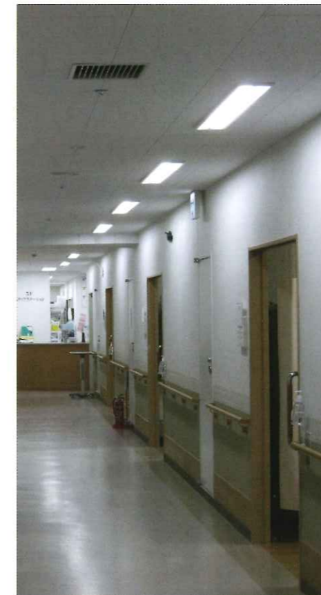
常備点灯廊下設置事例
