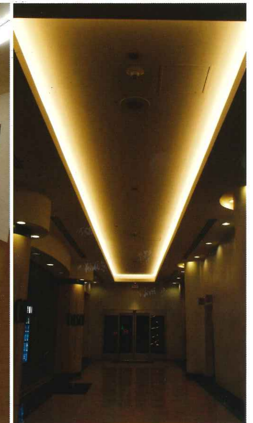
ホテル・旅館設置事例
