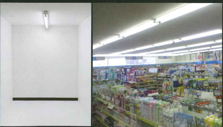
ドラッグストア設置事例
